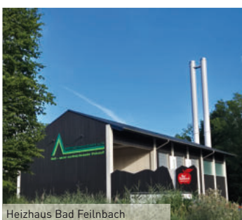
Heizhaus Bad Feilnbach
